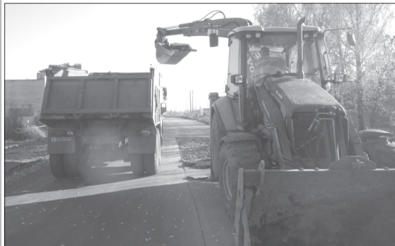
Строительство второй очереди дороги - дублера АТП-хлебокомбинат идет ускоренными темпами.
